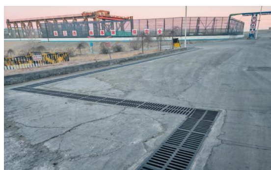
图注：富邦铜业雨水回收渠
