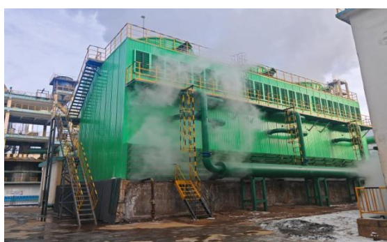
图注：富邦铜业消雾节水型冷却塔
